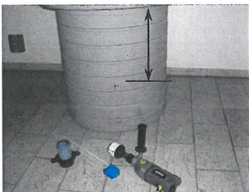
1. Markera för borrhålet ca 400 mm från flänsens underkant, mitt på sektion 5 uppifrån.
