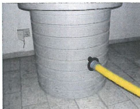
5. Anslut ett 50 mm kabelrör 50/42 med draglina.
