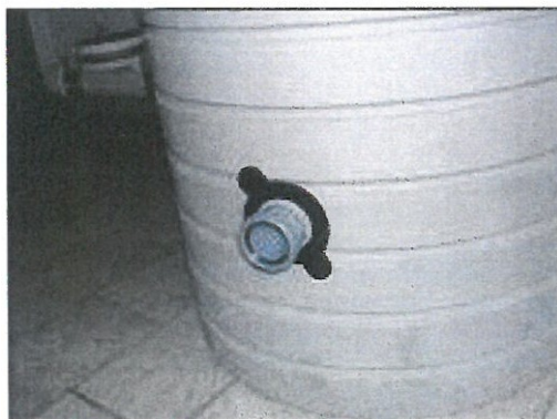
4. Gånga in röranslutningen på gummibussningen tills det blir tätt.
