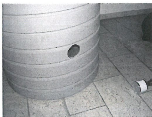
Borra med hålsåg 70-73 mm. 2. Smörj gängan på gummibussningen med tvålösning och tryck in den i förlängaren tills den bottnar.
