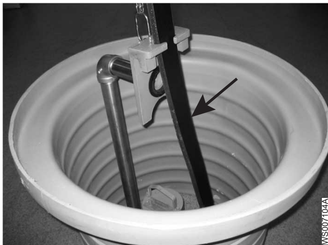
c) Håll pumpen borta från tryckanslutningen med backventilen.
