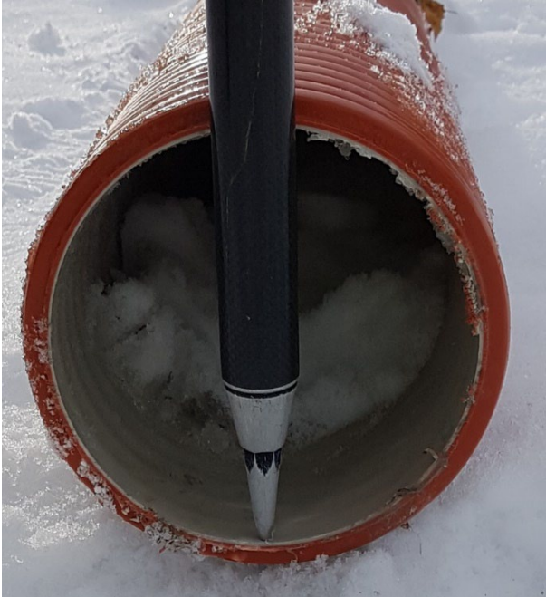
Bild – Vattengång i ledning.
