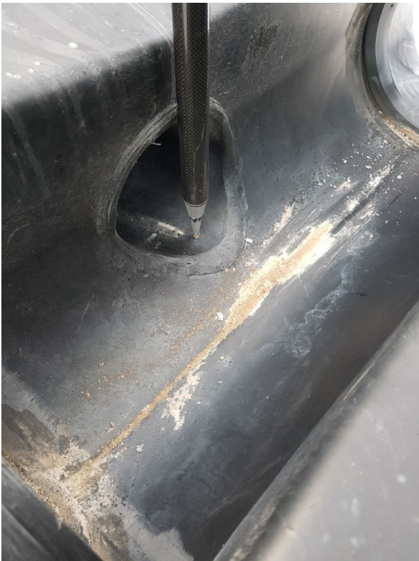
Bild – Vattengång på inkommande ledning till brunn.
